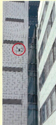
【ドローン調査状況】
