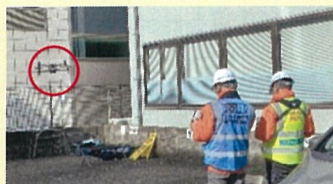
【ドローン操作状況】 協力会社：森基建材株式会社
