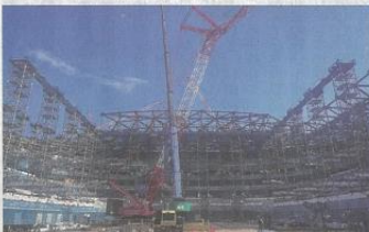
屋根鉄骨の建て方作業
