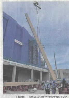
「樹形」鉄骨の建て方作業①②
